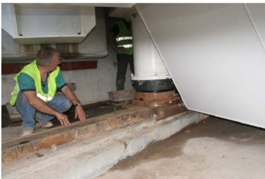
CARRIL RODADURA PUENTE GIRATORIO VALENCIA TRACK TREAD SWING BRIDGE OF VALENCIA VOIE ROULEMENT PONT GIRATOIRE DE VALENCIA
